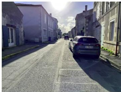
D114 circulation sur chaussée
