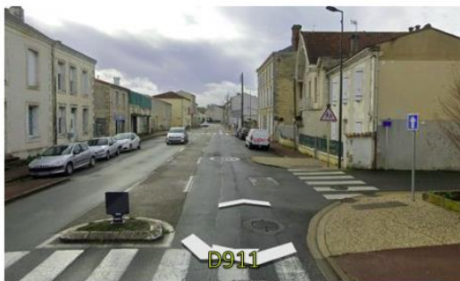
D911 circulation cycles en accotement
