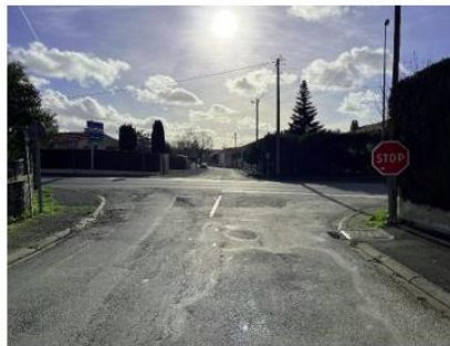
Traversée de la RD939
