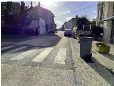
D114 Circulation vélo sur chaussée
